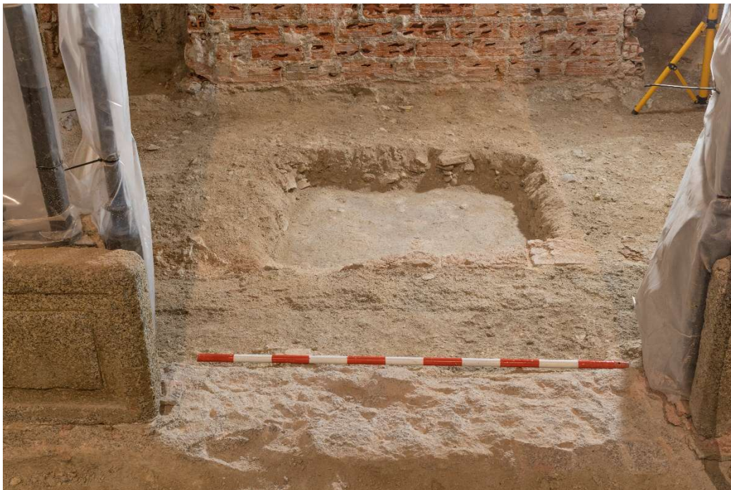
Detalle, desde el exterior de la capilla, del asiento de piedra de granito para la reja documentado durante la intervención arqueológica en el Santuario de la Caridad (2020-202), en el proyecto de rehabilitación integral del templo.
